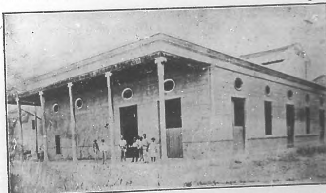
Vista exterior de la fábrica de hielo de los señores Vázquez y Compañía, de Manzanillo.
